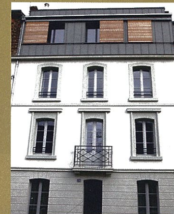
La façade côté rue...
